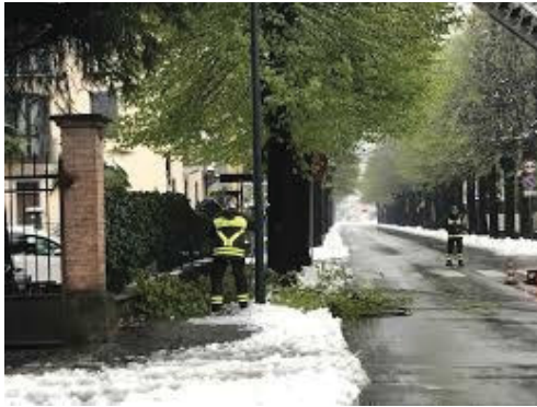
Foto n. 1 Rami pericolanti su sede stradale
