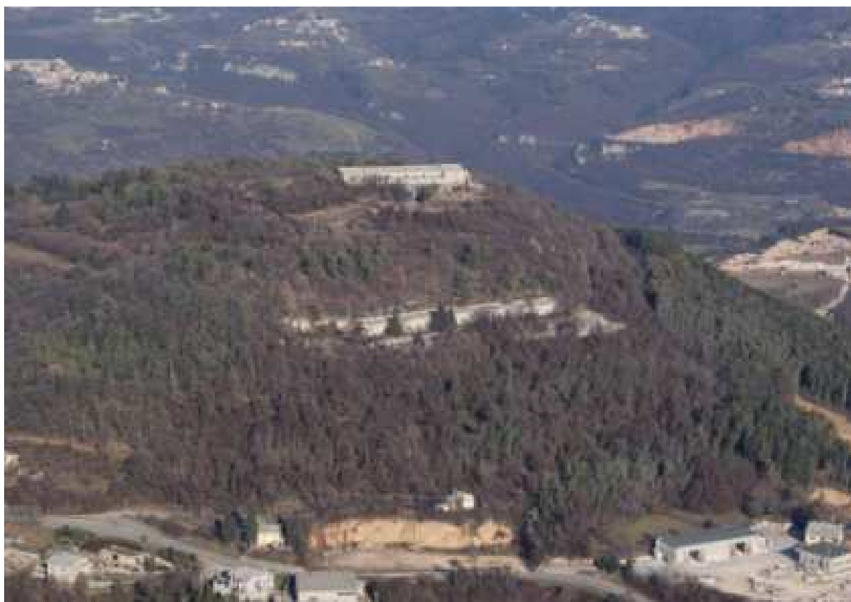
Vista complessiva della struttura
