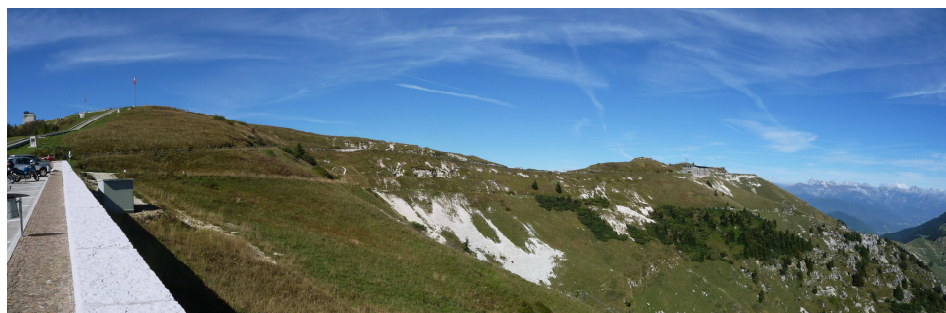
Vista del costone in cui è inserita la Galleria
