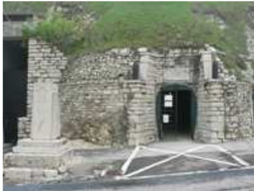
Ingresso della galleria
