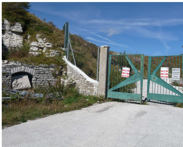
Ingresso in prossimità dell'accesso alla base militare A.M. (non agibile)
