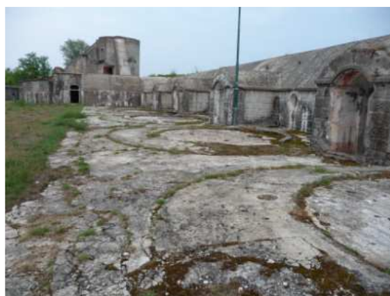
Cortile interno della batteria
