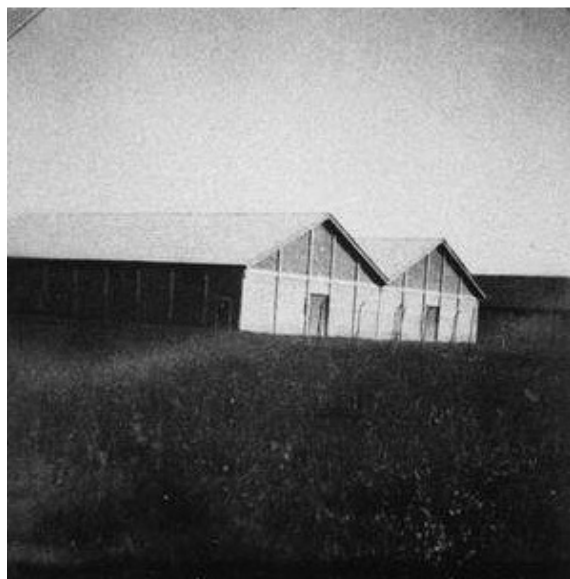
Fig. 1 vista di due hangars - foto archivio Lombardi
