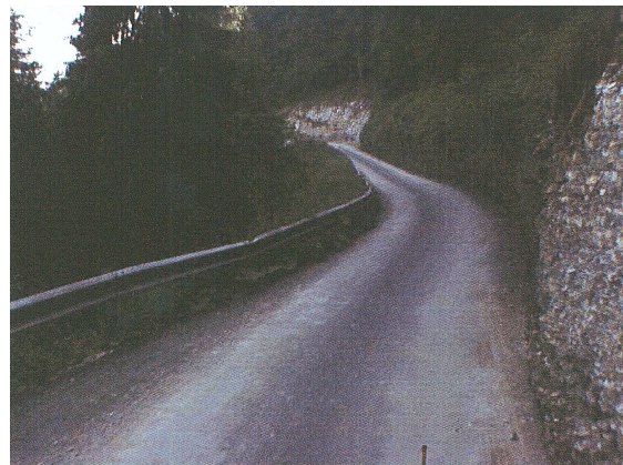
Tratto di strada dal Km 42+100 al Km 42+200
