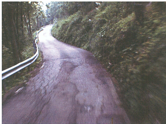
Tratto di strada dal Km 40+600 al Km 41+100
