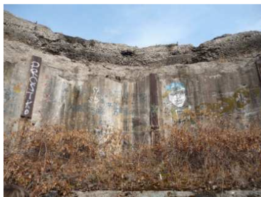
Interno dell'ex torre corazzata
