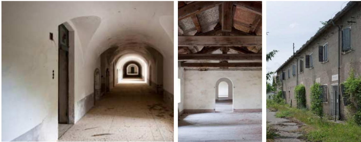
Nelle foto è individuabile lo stato attuale dell'edificio
