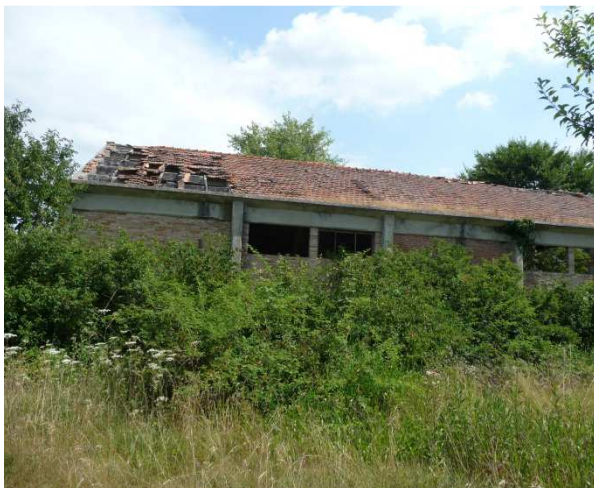
Fig. 11 stato della copertura dell'hangar in migliori condizioni
