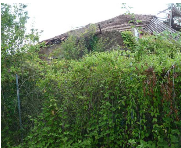
Fig.13 Circolo e alloggi ufficiali – parte della copertura
