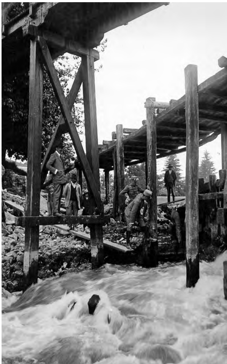
Il sigillo finale di una storia millenaria: i lavori di demolizione del mulino galleggiante di Cervarese (1917). All'esordio del Novecento tutti i mulini natanti sul Bacchiglione furono definitivamente rimossi per sgomberare il letto del fiume da quell'insieme di manufatti – scafi, paratie, palificate – che costituivano gli impianti di macinazione e che avevano caratterizzato per lunghi secoli il paesaggio lungo la via d'acqua.
